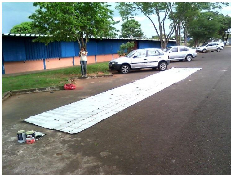
Figura 3.7 – PIT de 12000 mm de comprimento por 1600 mm de largura para instalação sobre o telhado da sala de Física.
