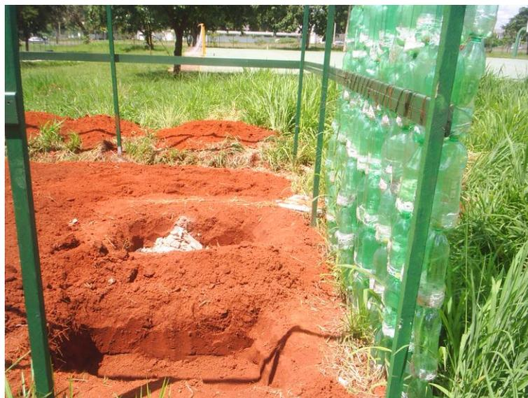
Figura 3.8 – Detalhe do dreno dentro do viveiro para escoamento de água pluvial e de irrigação das mudas de árvores..
