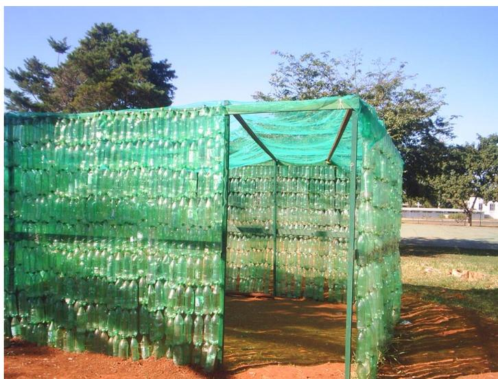
Figura 3.1.c – Vista lateral da parede de 8 m do viveiro com a porta de 1 m de largura por 2 m de altura e com o teto de tela verde plástica para sombreamento.
