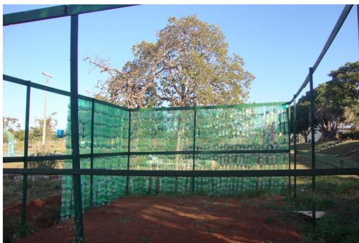
Figura 3.1.a – O viveiro de mudas de árvores com as paredes de garrafas PET fixadas com arame galvanizado liso na estrutura de madeira engastada no solo.
